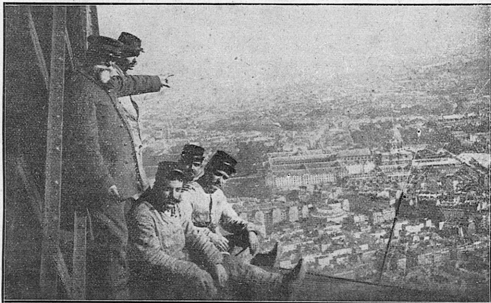
Le poste de télégraphie sans fil au sommet de la Tour Eiffel (à droite, on distingue l'antenne).
